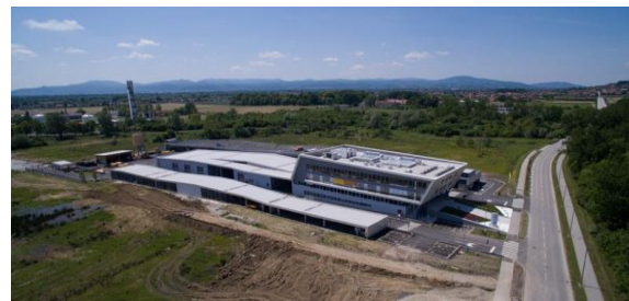
Poslovna zgrada Zapešić d.o.o.
